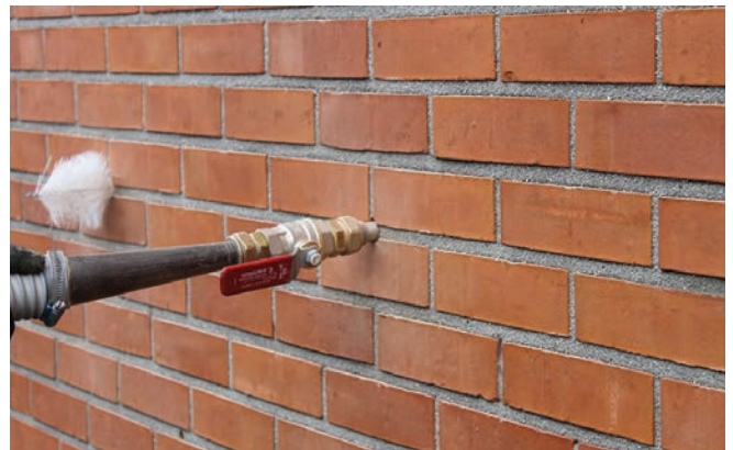
Ideaal voor het overschilderen van nageïsoleerde gevels.
